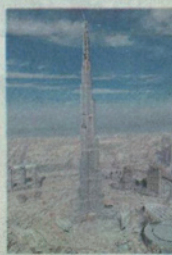
Il Burj Dubai in costruzione
