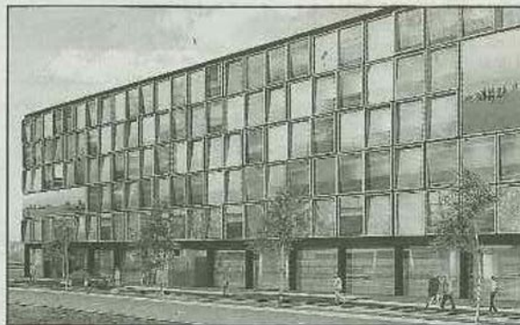
Un'immagine al computer dell'albergo in costruzione ad Amsterdam
